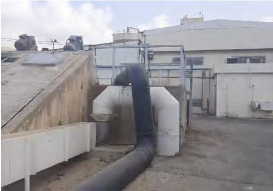
איור 13. שוחה הכניסה הקולטת את צינור הגרביטציה המגיע מכפ"ס וצינור תחנת שאיבת החרש
