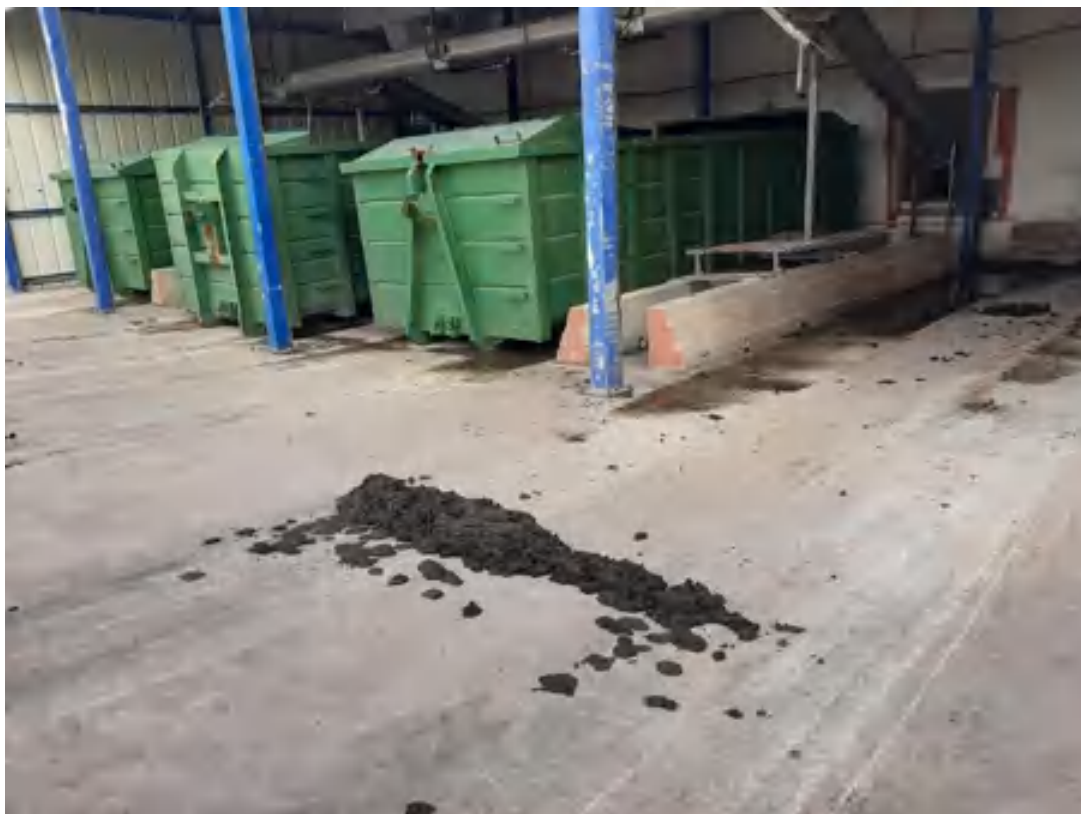
איור 14. מכולות לאגירת בוצה סחוטה פתוח לאוויר ובוצה מפוזרת על הרצפה
