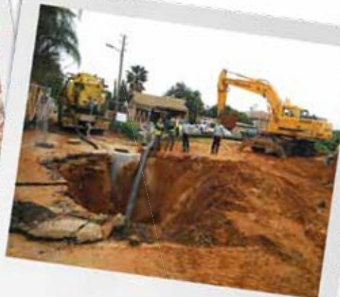
ביצוע עבודות ביוב בדרך כפר הדר בשיטה חדשנית של דחיקת הצנרת
